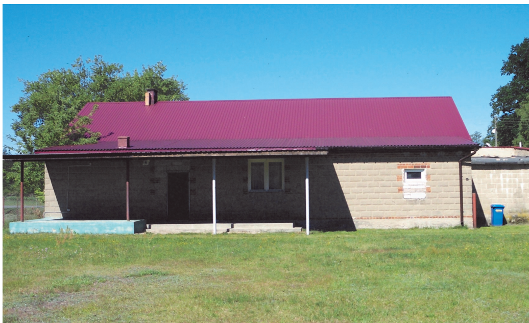
Świetlica Wiejska w Bibiannie przed remontem
